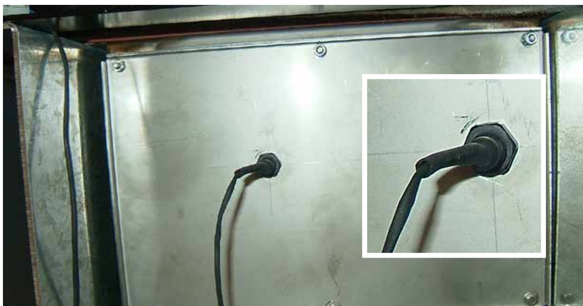
Положение датчика уровня конденсата
